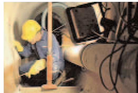
Rinnovo di condotte quale occasione per l'utilizzo di scambiatori e montaggio di uno scambiatore di calore in una condotta esistente (fonte gwa 6/2007)
