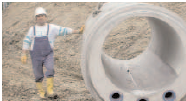
Rinnovo di condotte quale occasione per l'utilizzo di scambiatori e montaggio di uno scambiatore di calore in una condotta esistente (fonte gwa 6/2007)
